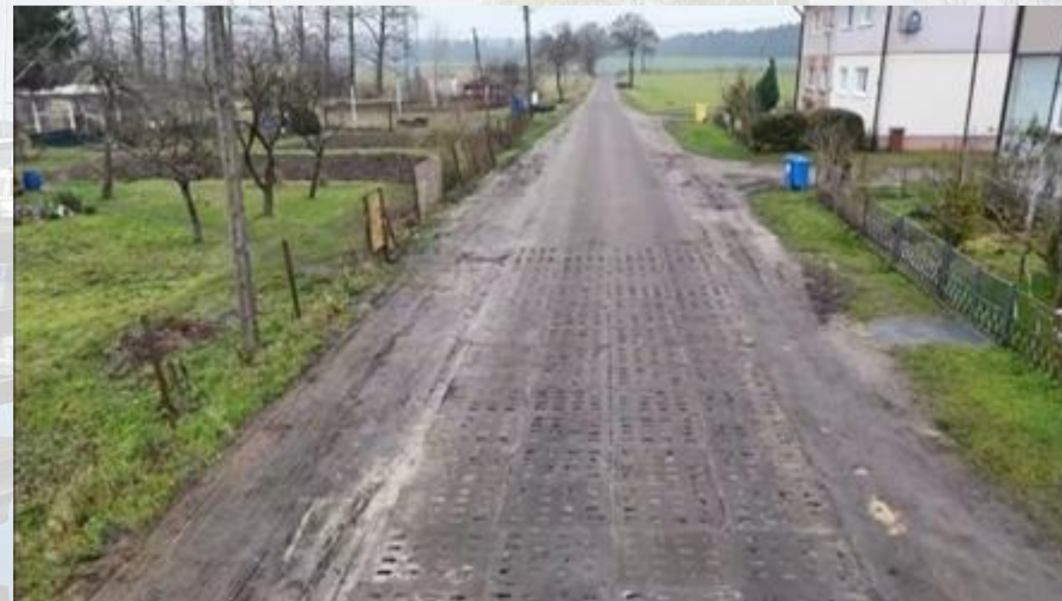
Wykonana nawierzchnia w m. Drahimek
