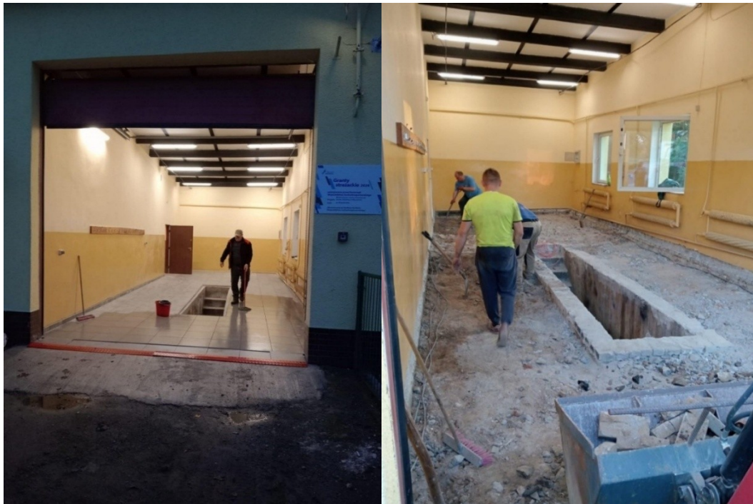
Zdjęcie nr 20,21: Modernizacja remizy Ochotniczej Straży Pożarnej w Kluczewie”.
