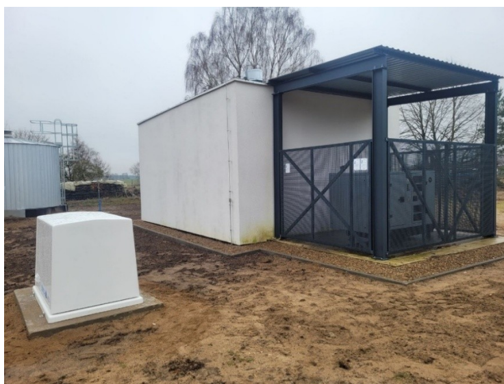
Zdjęcie nr 1. Stacja uzdatniania wody w Broczynie
