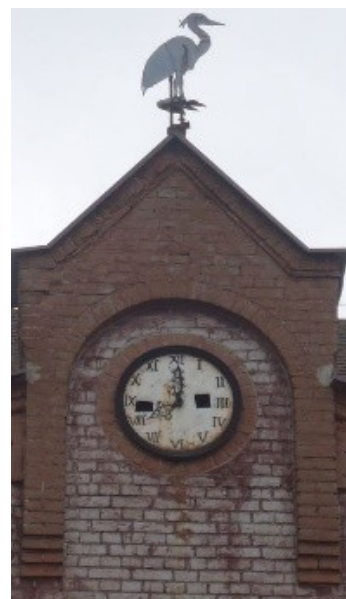
Zdjęcie nr 46,47: Kościoła pw. Trójcy Św, oraz XIX-wiecznego oraz zegara zlokalizowanego przy budynku Szkoły Podstawowej przy ulicy Słonecznej,
