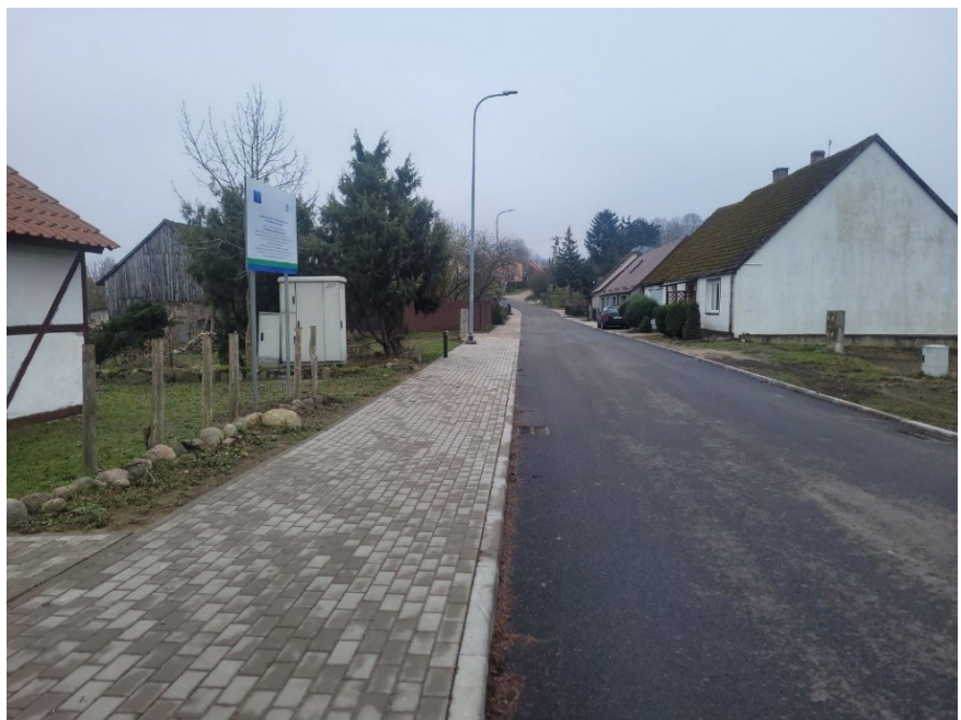
Zdjęcie nr 5: Remont drogi w m. Sikory
