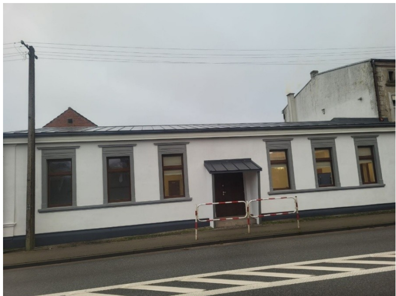
Zdjęcie nr 9: Remont budynku świetlicy wiejskiej w m. Broczyno wraz z wyposażeniem
