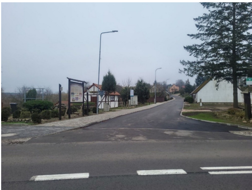
Zdjęcie nr 4: Remont drogi w m. Sikory
