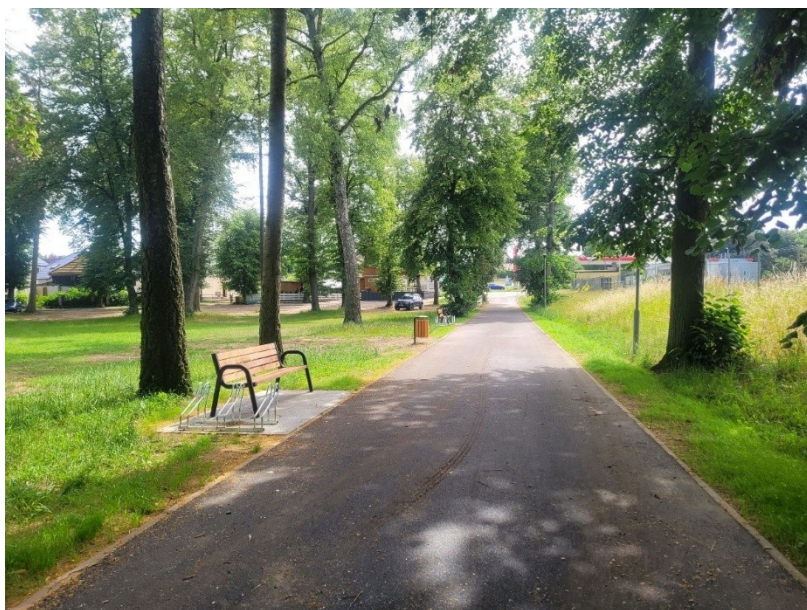
Zdjęcie nr 6: ścieżka pieszo-rowerowa w Czaplinku - odcinek od ul. Parkowej do ul. Nadbrzeże Drawskie
