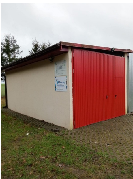
Zdjęcie nr 22: Modernizacja bramy budynku garażowego Ochotniczej Straży Pożarnej w Trzcińcu
