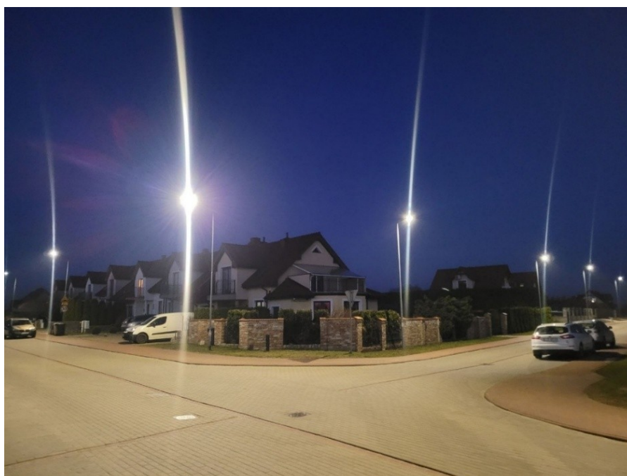
Zdjęcie nr 8: Modernizacja infrastruktury oświetleniowej na terenie gminy Czaplinek
