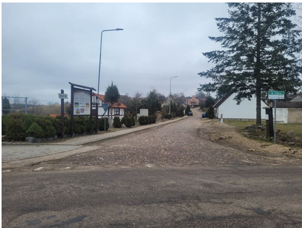
Droga w Sikorach przed przebudową
