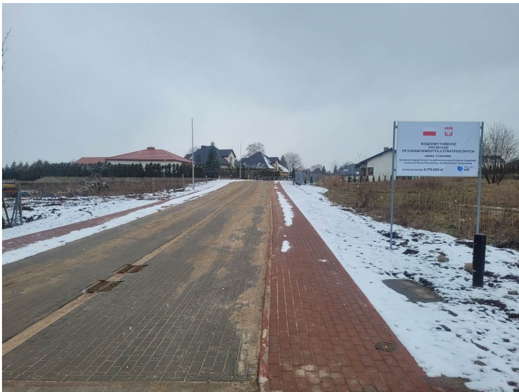
Ulica Jarzębinowa w Czaplunku w trakcie przebudowy
